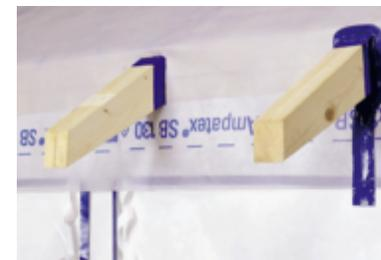
Klebebänder mit Dichtfunktion stellen **Folienanschlüsse zu Bauteilen** sicher. Sie bestehen meist aus Acryl.
