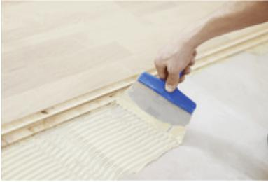
Klebstoff stets dünn, gleichmässig, überall, rasch und bei Laubhölzern beidseitig auftragen.
