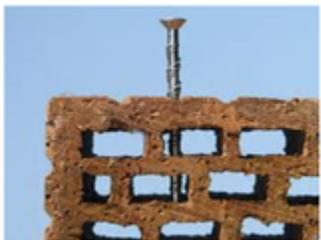
Bei der Direktmontage wird der Montagegegenstand ohne Dübel mit speziellen Schrauben im Untergrund befestigt.
