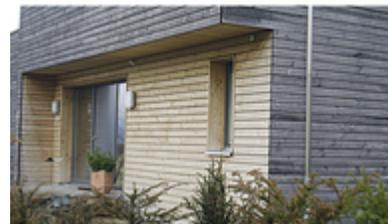
**Lignin** an der Holzoberfläche wird durch die **Sonne** aus dem Holz **herausgelöst** und durch den **Regen herausgewaschen**.
