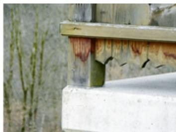
Wie ist diese Pfostenabstützung in Bezug auf konstruktiven Holzschutz zu beurteilen?
