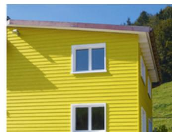
Was muss beim Einbau von **liegender** (horizontaler) Schalung mit **Nut und Kamm** berücksichtigt werden?
