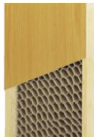
Mittellage aus Papierwaben, Spanplatten- oder Röhrenspanstreifen. Decklage meist Faserplatten.
