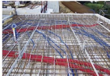
Mehradrige Kabel werden nach dem Erhärten des bewehrten Betons mit hydraulischen Pressen gespannt.
